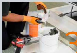
Katalysator zugeben
