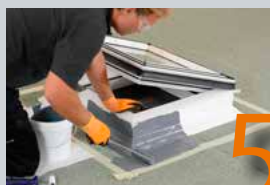
Erste Schicht auftragen
