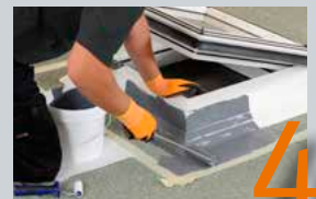
Erste Schicht auftragen
