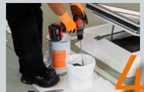
Flüssigkunststoff anrühren
