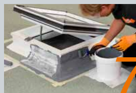
Zweite Schicht auftragen
