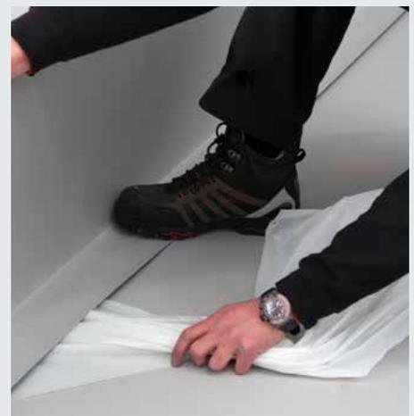
Anschluss an die Attika mit SK-Zuschnittbahn, Zuschnitt vorformen, Schutzfolie oben und unten parallel zur Kehllinie einschneiden und schritt-weise abziehen, Zuschnitt andrücken
