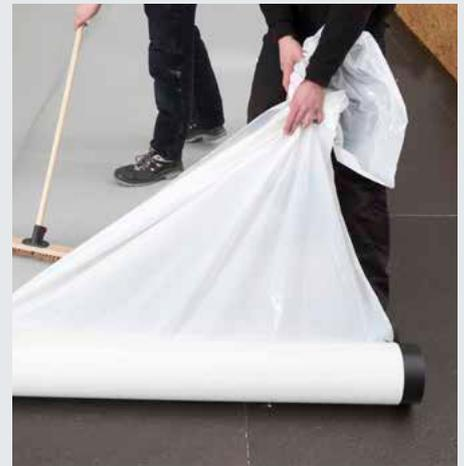
Abziehen der Schutzfolie parallel zur Rolle, Andrücken der Dachbahn auf den Untergrund mit einem sauberen, breiten Besen oder einer Rolle
