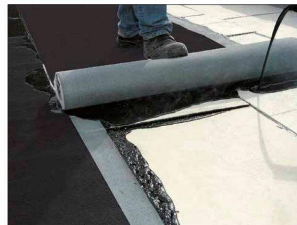
Evtl. sind zur Vermeidung einer Verklebung ausgetretene Bitumenmassen mit Feinbestreuung abzustreuen.
