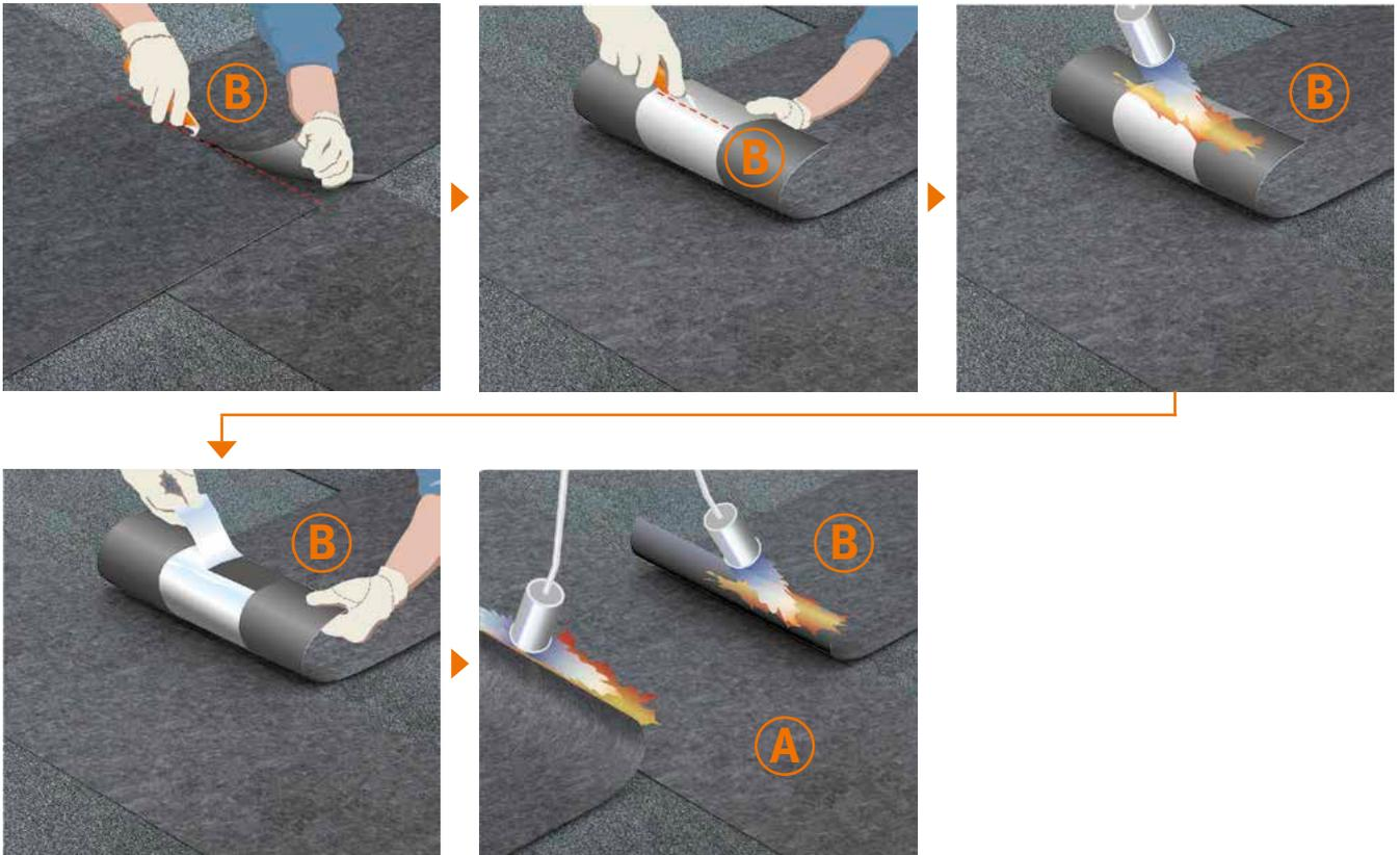
Das Dehnfugenband **B** mittig über der Fuge platzieren, dabei den Aluminiumstreifen nach unten ausrichten. Auf beiden Seiten eine Überlappung von 12,5 cm im Kreuzfugenbereich markieren.
