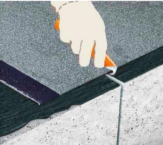
Geeignete Bauder Dampfsperre verlegen und über der Bewegungsfuge einschneiden.
