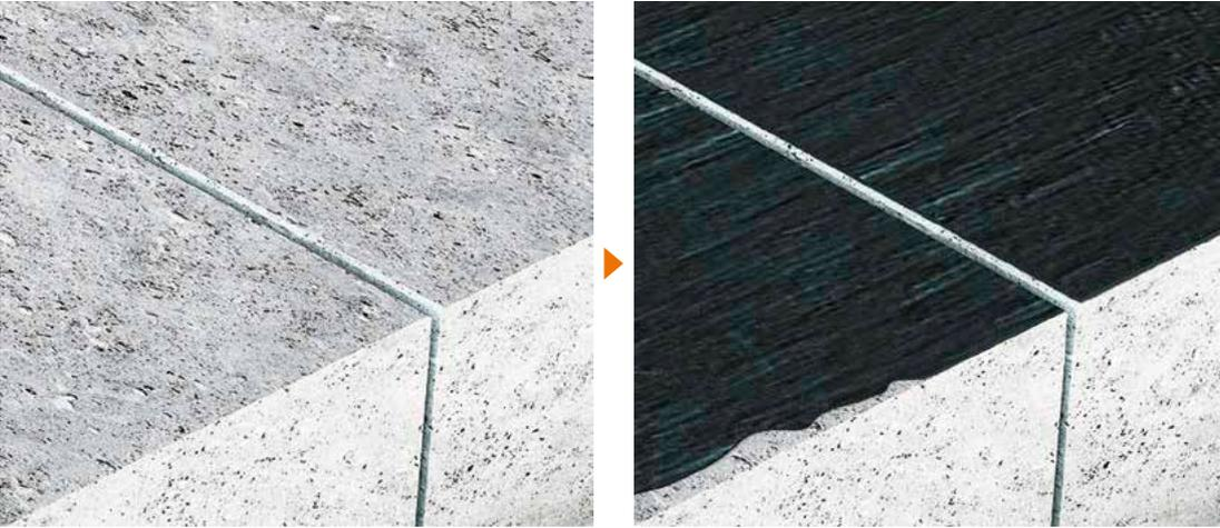
Auf vorbereitetem Betonuntergrund Bauder Bitumen-Voranstrich aufbringen und entsprechend den Verarbeitungsvorgaben abtrocknen lassen.
