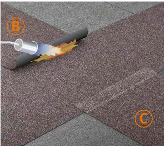
Eine zweite und dritte ca. 70 cm breite, unterseitig folierte oder besandete, erste Abdichtungslage **B** und **C** zentriert über die Kreuzfuge verlegen und beidseitig auf einer Breite von 15 cm mit der Abdichtungsoberlage verschweißen. Dabei soll mittig über der Bewegungsfuge ein unverschweißter Bereich von ca. 40 cm Breite bleiben.
