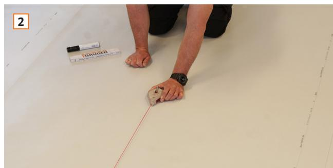
Dekorprofil mit **Anlegehilfe** ausrichten und lagestabil halten (z. B. Holzbohle oder Schiene).
