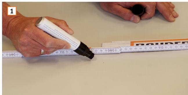
**Dekorprofil-Position** mit Hilfe einer Schlagschnur markieren (oder mit Schiene und Stift).
