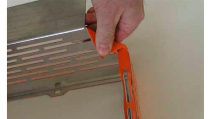
Perforation der hinteren Ecken bis zur Schräge durchtrennen, Rückwand und Ecken nach innen falten
